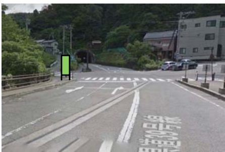
⑤トンネル前交差点
